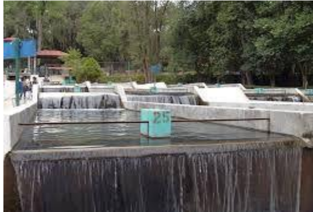
Figure 2 : disposition des bassins en série ( https://www.shutterstock.com/fr ).
