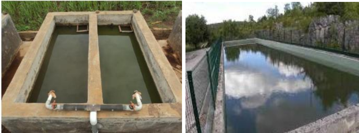
Figure 7 : Bassin en béton ( https://www.shutterstock.com/fr ).
