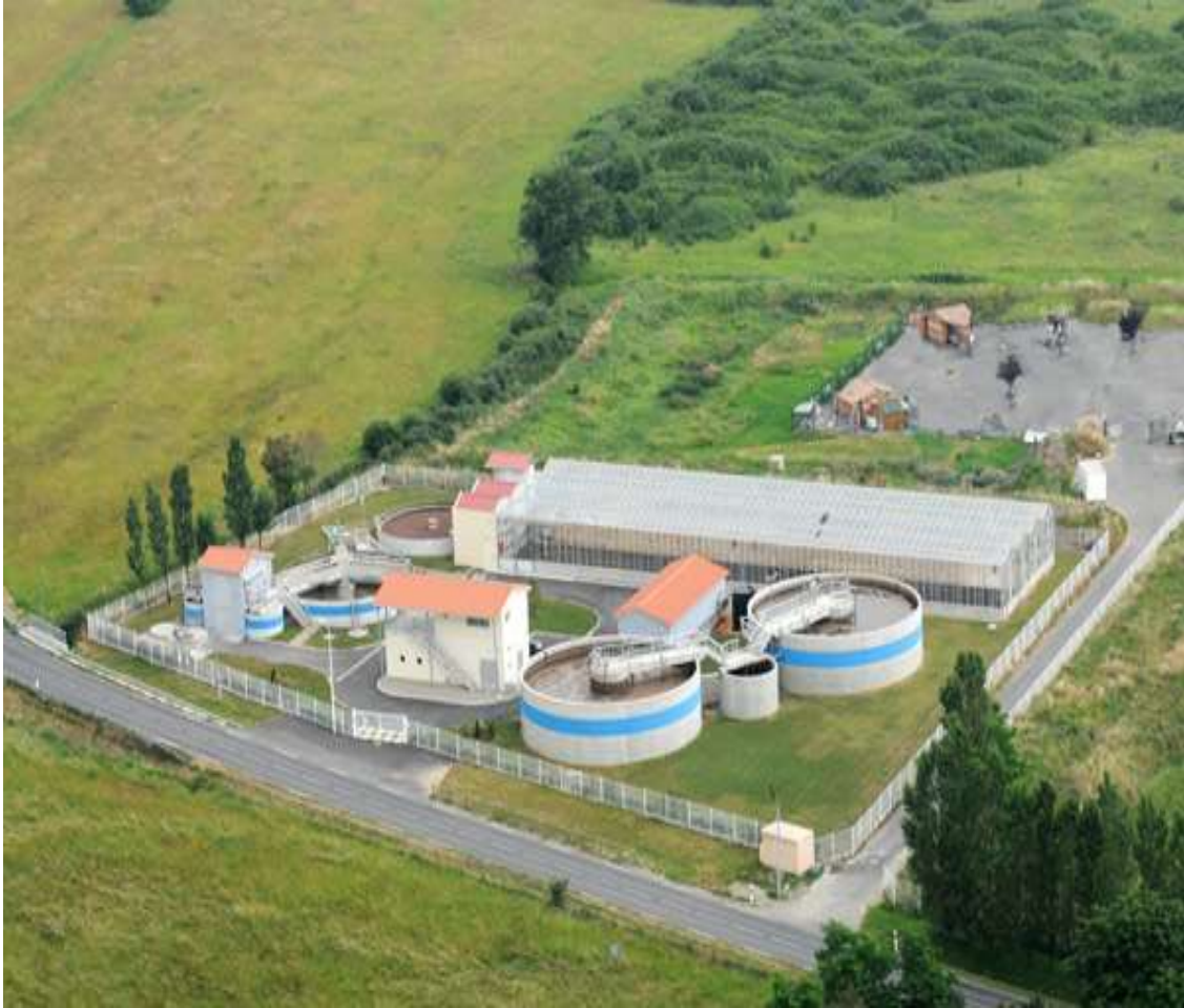
Figure 17 : Photographie d’une station d’épuration (Google, 2018).
