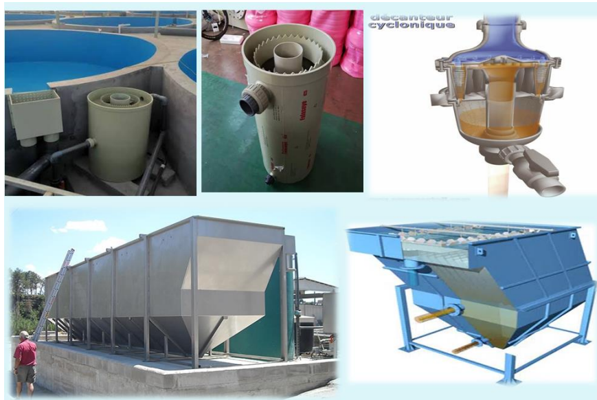
Figure 14.a : décanteur cyclonique et lamellaire (Ifremer Palavas - G. Lemarié 2009).
