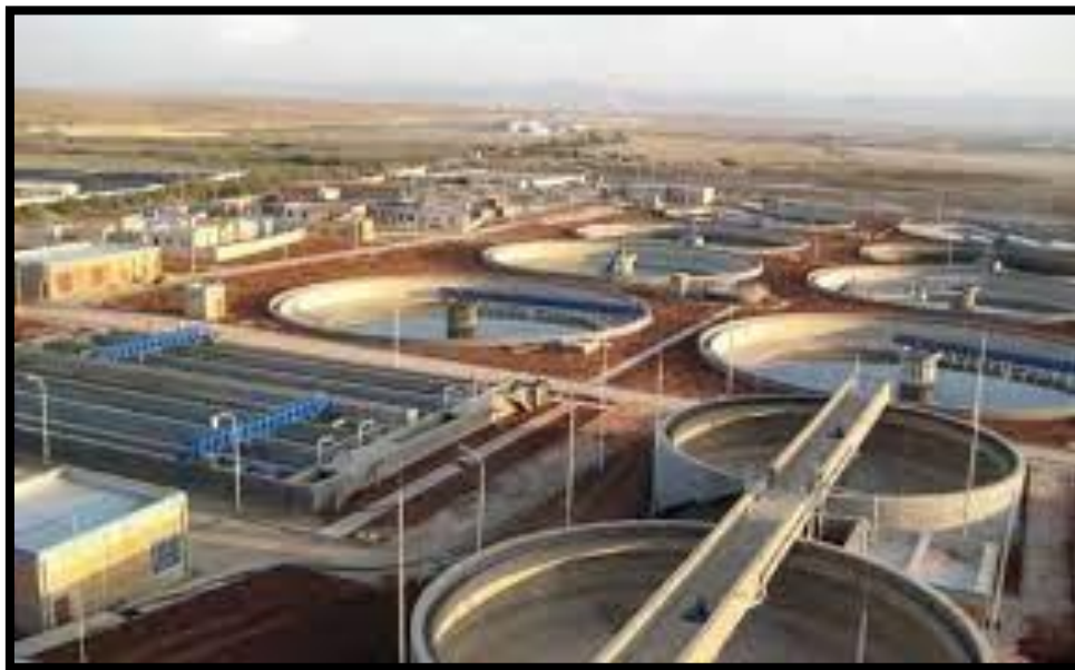
Fig. 2 : Image d'une station d'épuration (algerie-eco.com).
